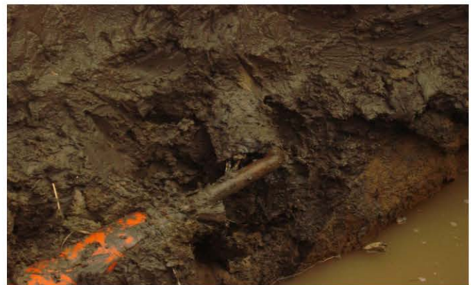
图为80100至80102施工地点过道三处直角弯其中一处
