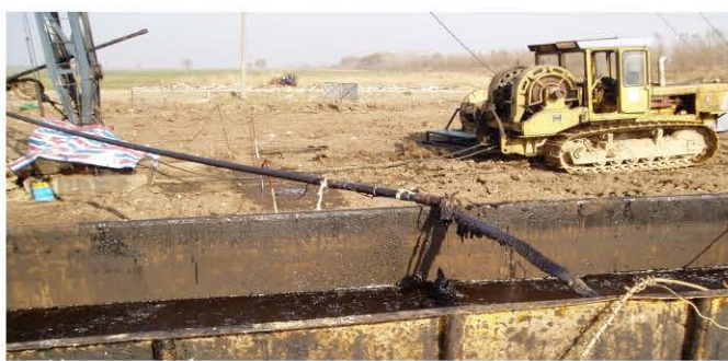
图10 出口管线保温电缆示意
