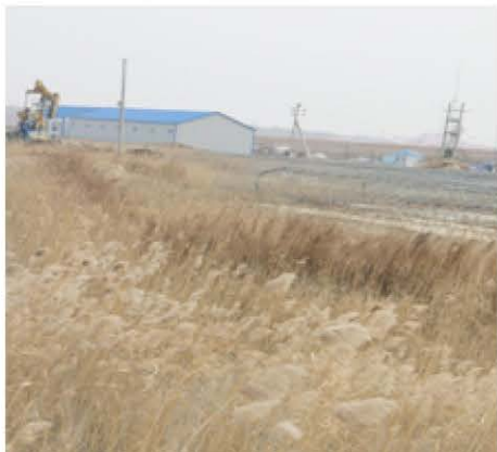
图为1#罐区管线穿带路段苇塘
