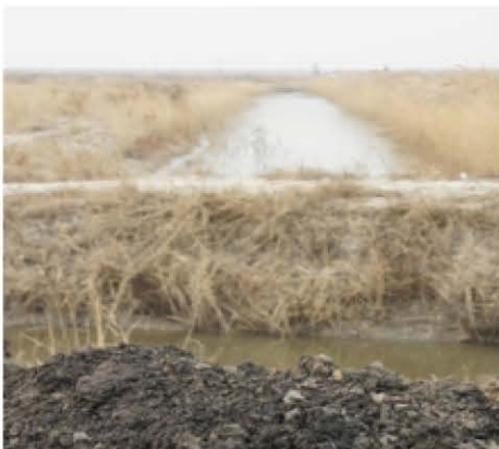
图为1#罐区管线穿带路段水渠
