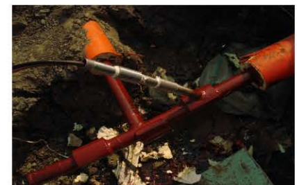
图为现场安装的密封装置
