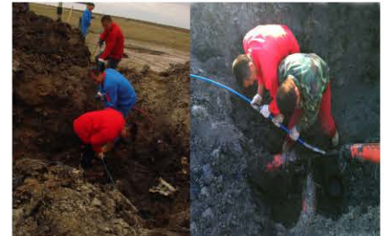
图为工作人员现场穿引线
