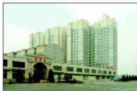
4. 太原晋吴苑变电所办公楼
