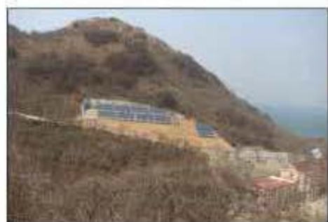
10. 大连三山岛军队某部光伏发电自限温蓄能地面辐射供暖及生活用电项目
