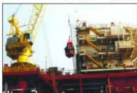
12. 海上石油平台总控室自控温电热地板采暖项目
